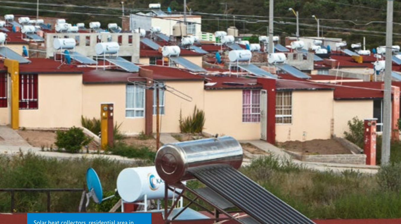
Solar heat collectors, residential area in Villa de las Palmas Aguascalientes.
